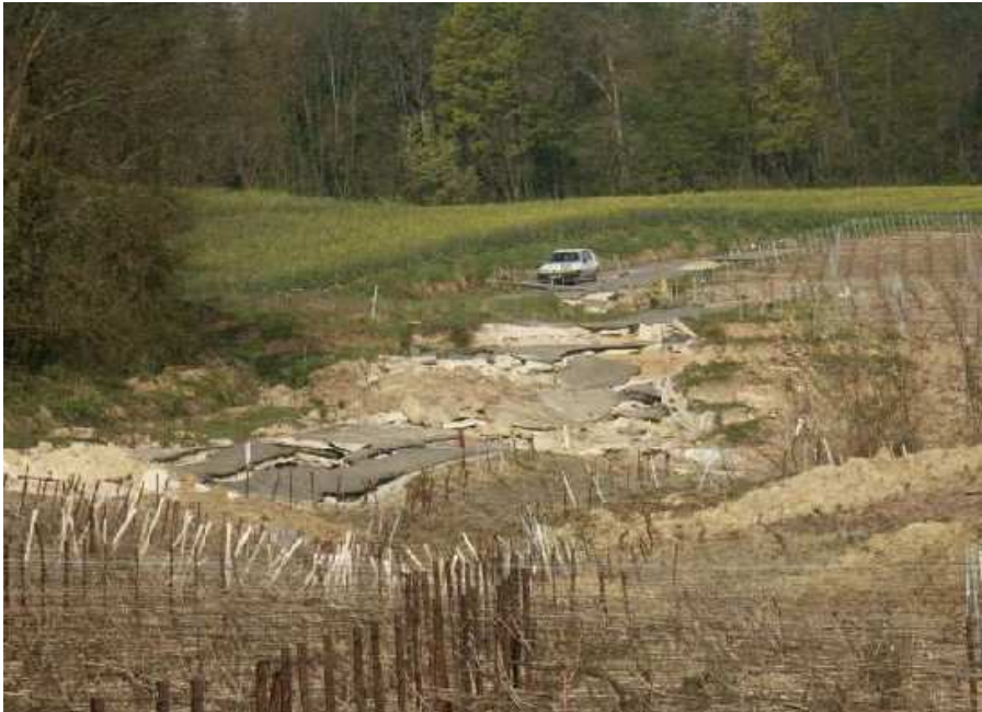
Illustration 4: dégâts occasionnés sur la route de Boursault à Vauciennes
